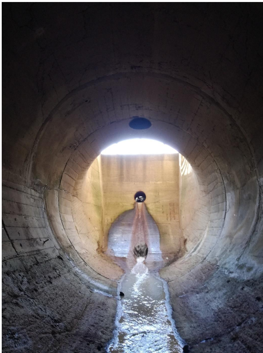
Fig. 47 – Fine galleria presso la Torre di presa e scarico con particolare tubi di scarico e in alto foro per il passaggio del tubo acquedotto
