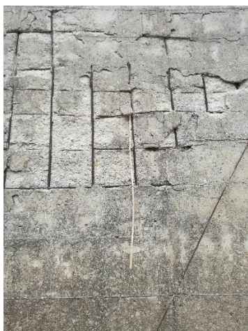
Fig. 18 – Particolare interasse ferri sezione n.2
