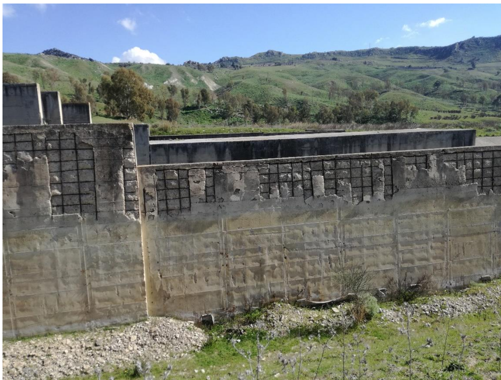
Fig. 53 – Particolare di diffusi distacchi dei copriferrì con ossidazione delle armature
