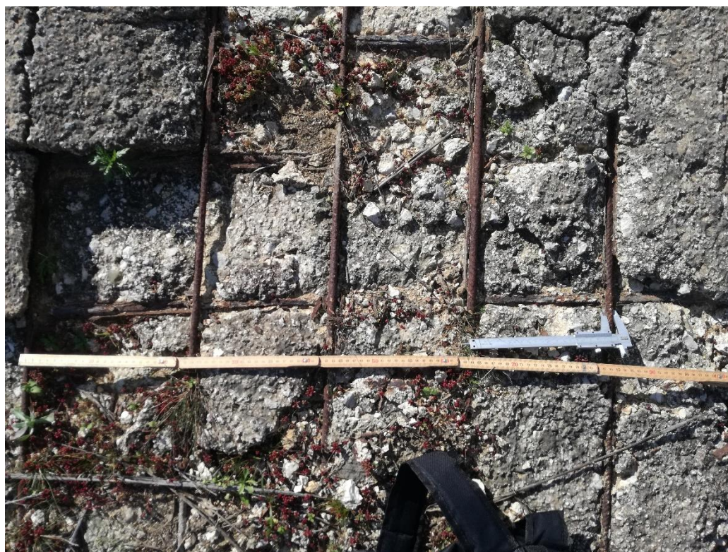
Fig. 57 – Particolare armature ossidate
