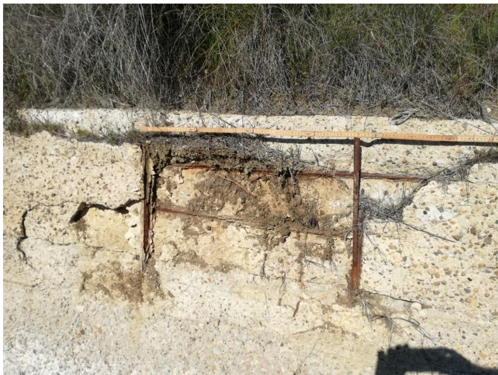
Fig. 24 – Particolare distacco copriferro e ossidazione armature sui muri laterali
