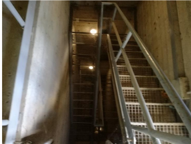
Fig. 32 – Particolare scala in profilati e griglie metalliche
