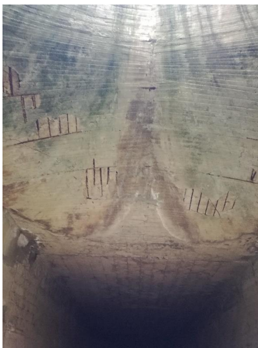
Fig. 43 –Particolare distacco dei copriferrì e ossidazione delle barre di armatura
