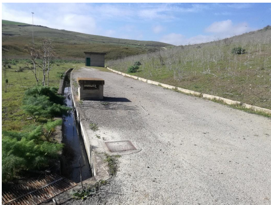
Fig. 30 – Torre di drenaggio con in primo piano il torrino di ventilazione est
