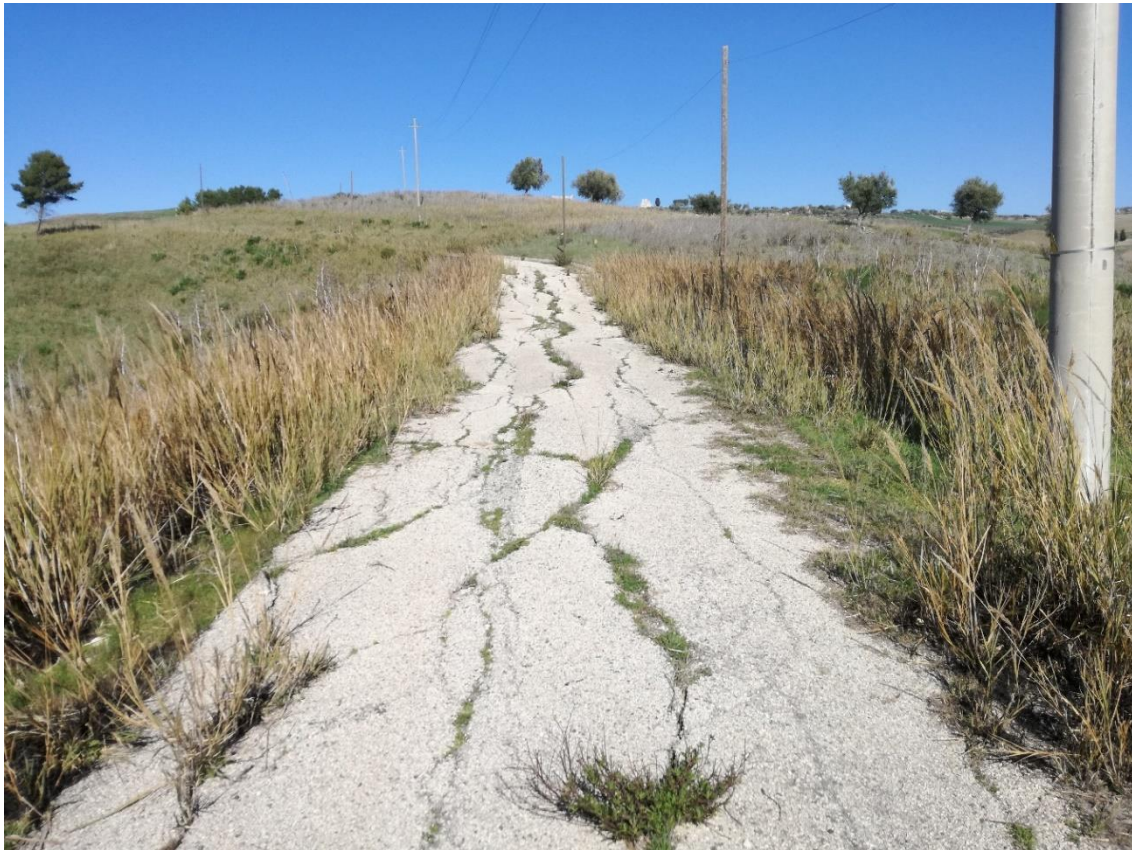
Fig. 21 – Particolare 2 lesioni longitudinali nel pacchetto stradale
