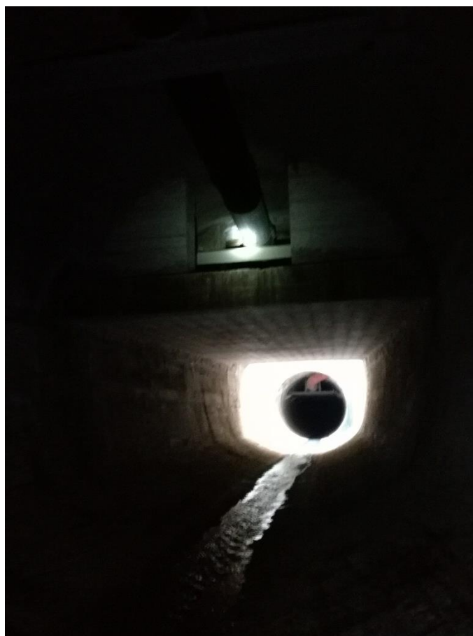
Fig. 40 – Galleria destra in corrispondenza del Calice sfioratore con restringimento della sezione per la presenza del primo torrino aeroforo
