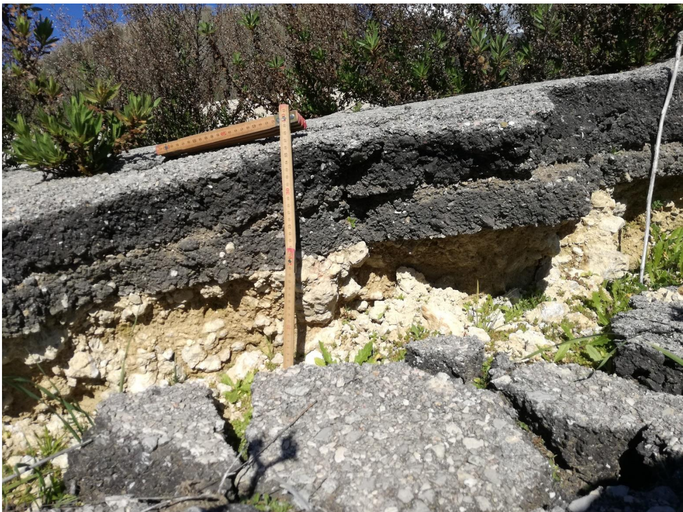
Fig. 25 – Frana del corpo stradale con particolare strati neri della pavimentazione
