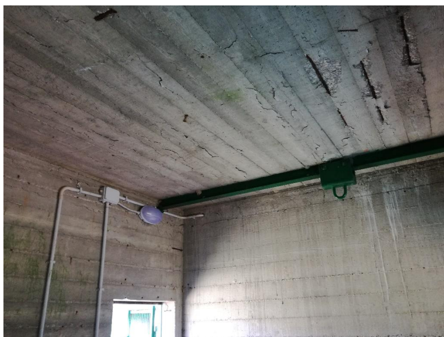
Fig. 31 – Solaio di copertura - armature ossidate con particolare del gancio di sollevamento pompe acque cariche
