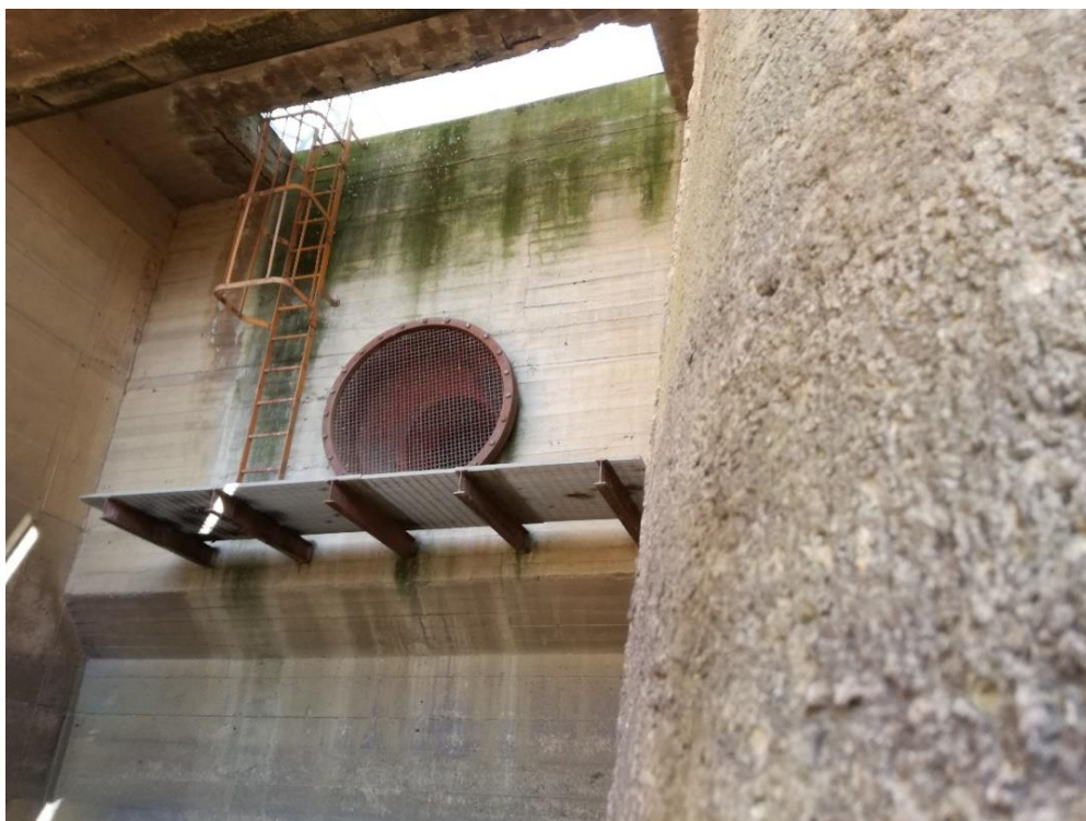
Fig. 4 – Vano principale - Tubo di presa acquedotto
