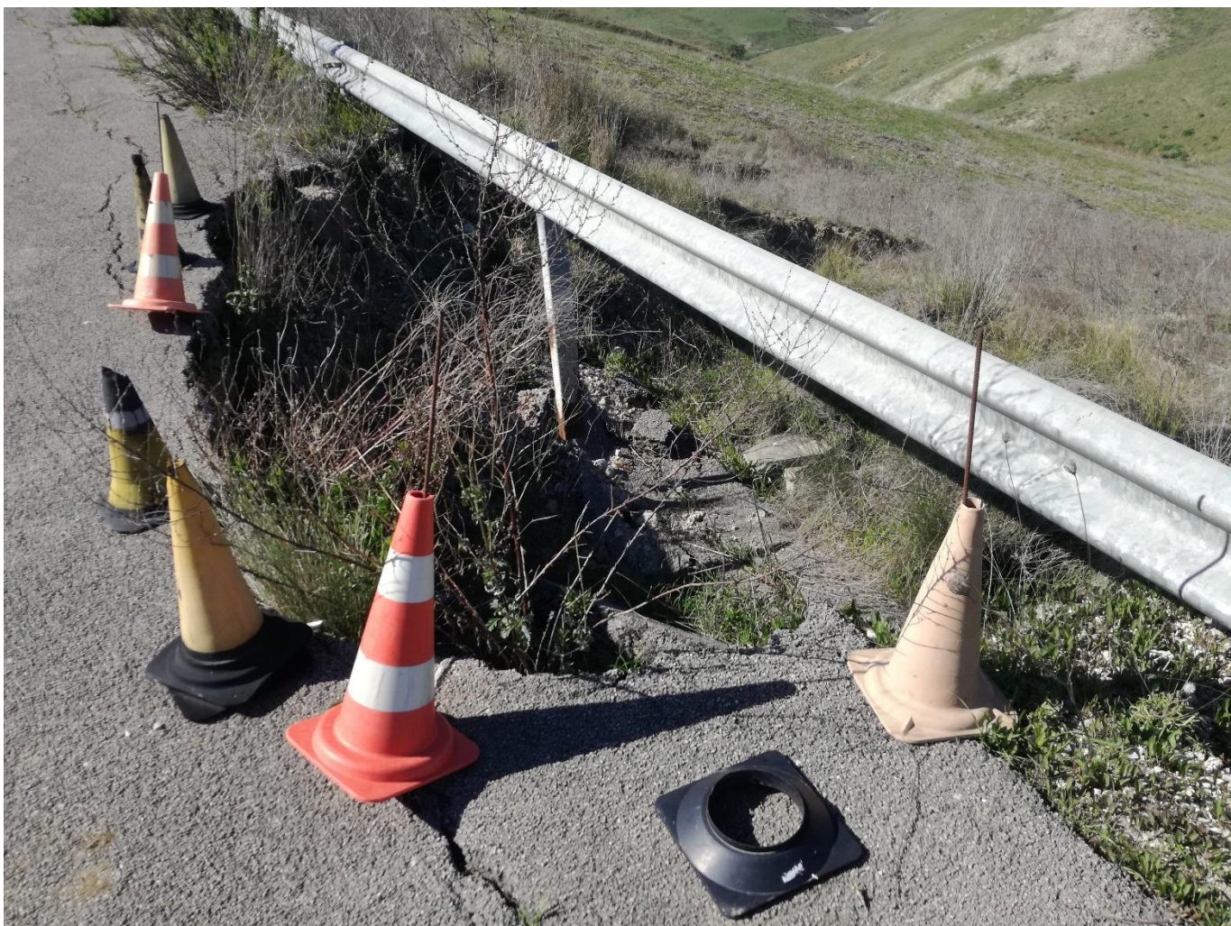
Fig. 20 – Fenomeni di smottamento del corpo stradale
