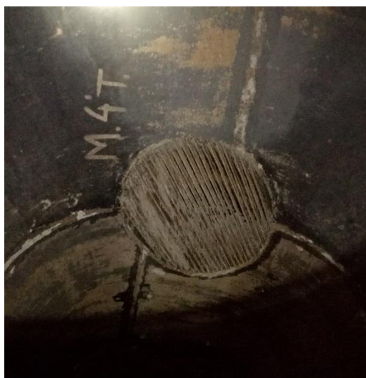
Fig. 46 – Flangia cieca su bocca di ispezione acquedotto
