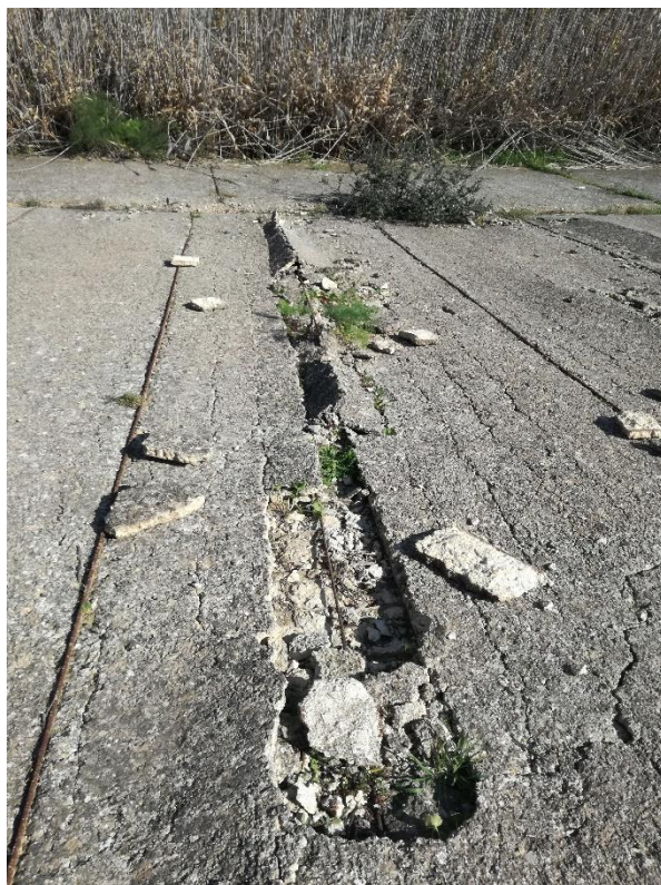
Fig. 56 – Deterioramento calcestruzzo sulle sponde
