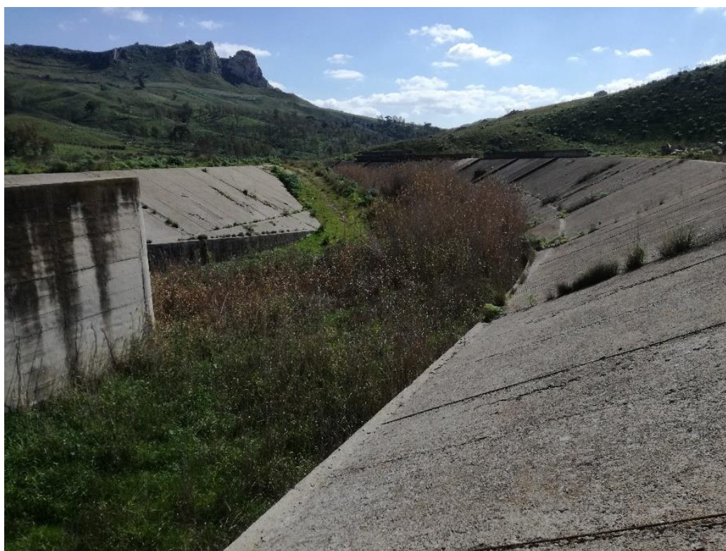
Fig. 55 – Canale di restituzione –fenomeni di smottamenti di terreno in alveo
