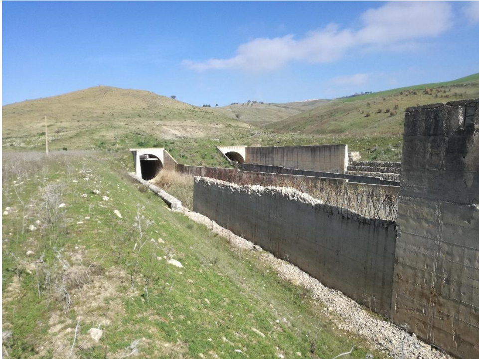
Fig. 51 – Crollo parziale del muro di contenimento di valle della vasca
