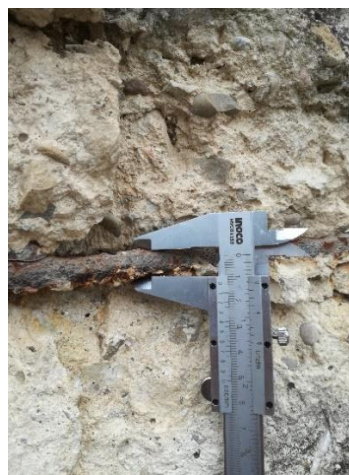
Fig. 19 – Particolare ossidazione delle armature sezione n.2
