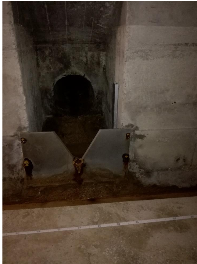
Fig. 36 – Particolare innesto tipo del canale di drenaggio nel cunicolo
