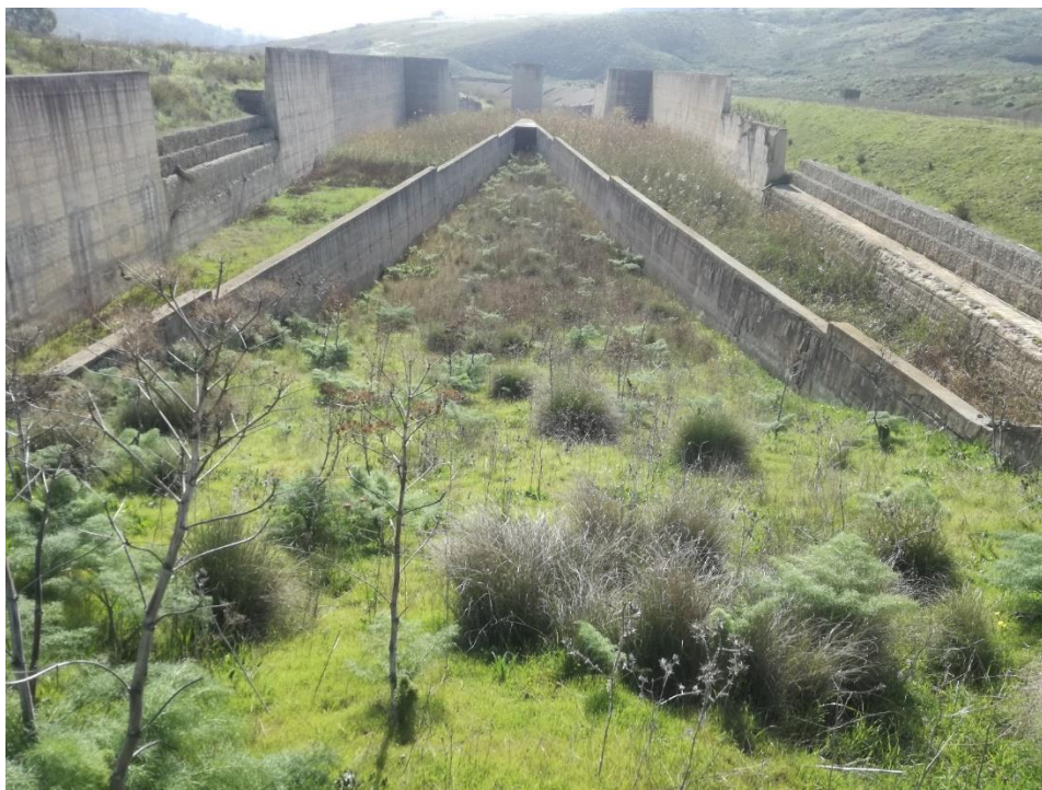
Fig. 48 –Vasca di Dissipazione-vista lungo l'asse longitudinale
