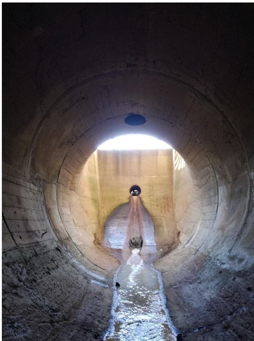
Fig. 7 – Particolare dei tubi di scarico di fondo in ingresso alla Torre e in alto il foro per il passaggio del tubo di presa dell'acquedotto verso la Torre di controllo mancante
